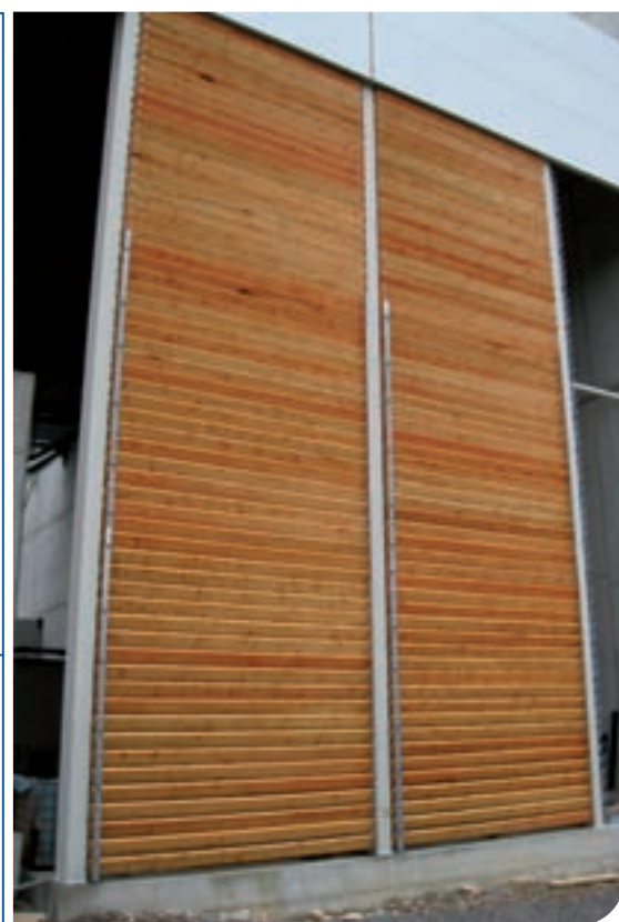
Fotos © HASLINGER STAHLBAU
