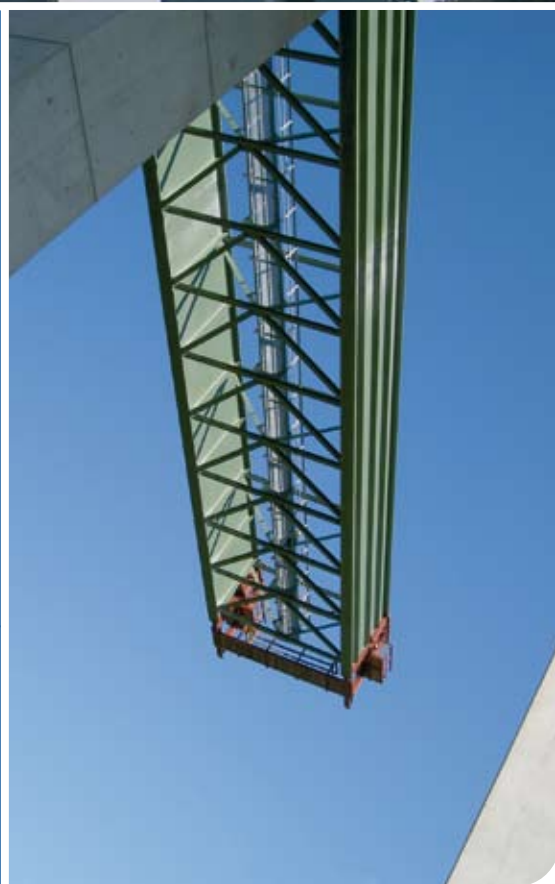
Fotos © HASLINGER STAHLBAU
