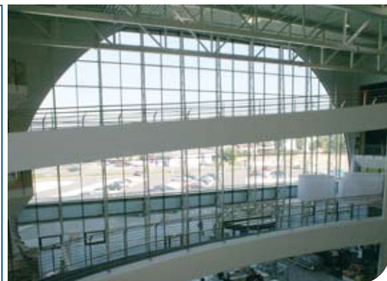
Fotos © HASLINGER STAHLBAU
