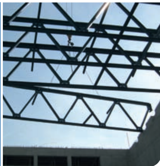
Fotos © HASLINGER STAHLBAU
