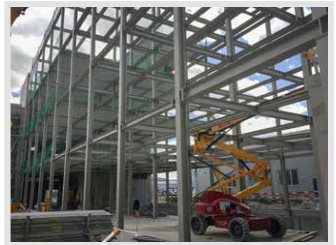
© Fotos: HASLINGER STAHLBAU
