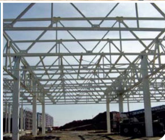
Fotos © HASLINGER STAHLBAU
