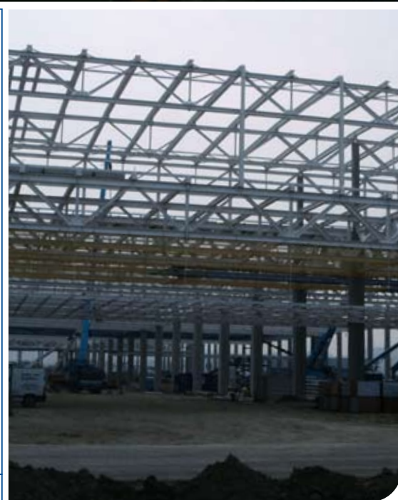
Fotos © HASLINGER STAHLBAU
