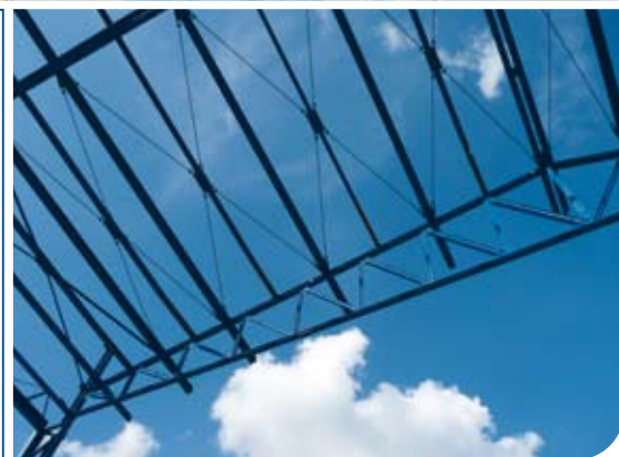
Fotos © HASLINGER STAHLBAU
