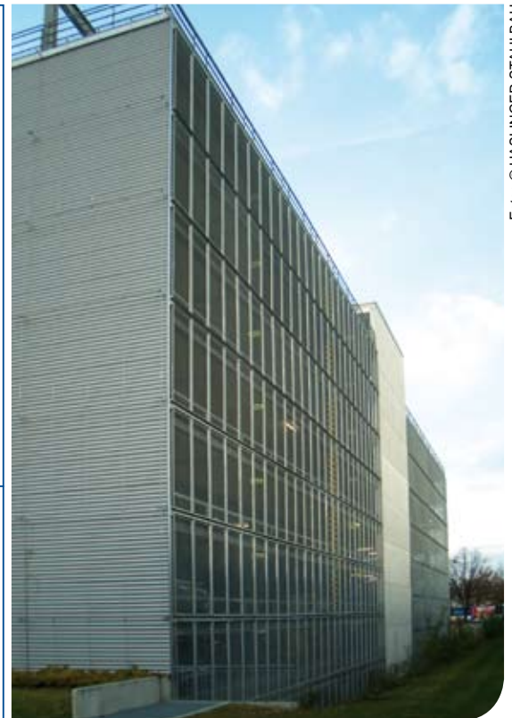
Fotos © HASLINGER STAHLBAU
