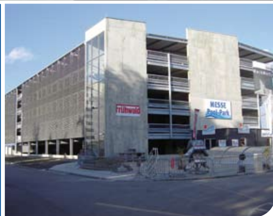
Fotos © HASLINGER STAHLBAU
