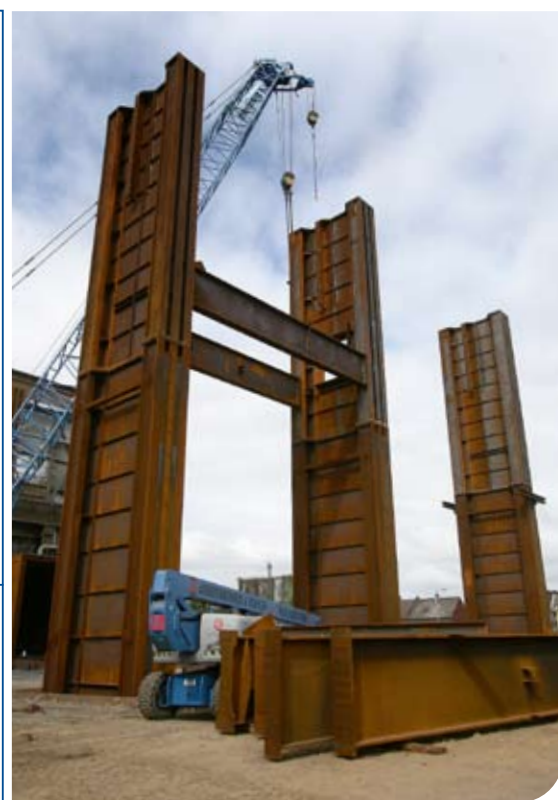
Fotos © HASLINGER STAHLBAU
