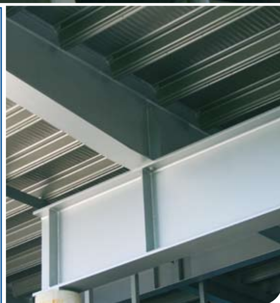
Fotos © HASLINGER STAHLBAU
