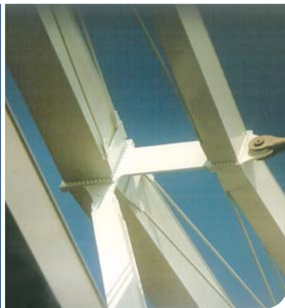
Fotos © HASLINGER STAHLBAU
