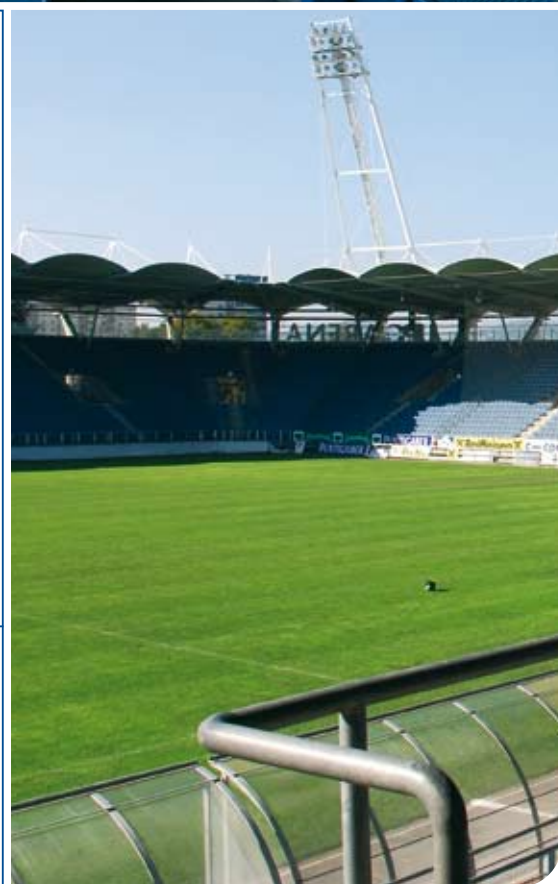
Fotos © HASLINGER STAHLBAU
